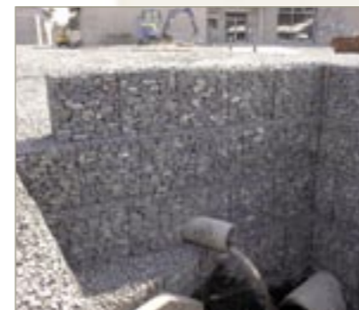
Gabion jako integralna część konstrukcji drenażowej, Irlandia Północna – 2002 rok
