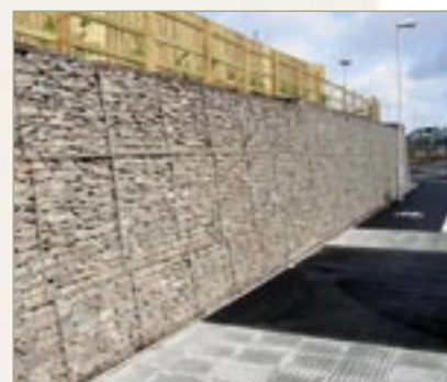
Centrum handlowe – graniczna ściana oporowa
