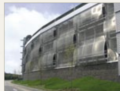
Wolnostojąca okładzina z Trapionów™ w wielopiętrowym parkingu. Clarence Dock, Leeds Anglia – 2004 rok.
