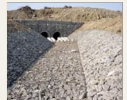
Wyłożenie przepustu z wykorzystaniem materacy przy A465 na wyjeździe z Valley Road, Południowa Walia - 2004 rok.
