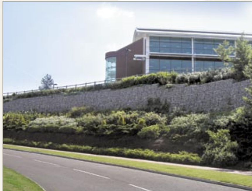
Grawitacyjna ściana oporowa z Gabionów w Daresbury Business Park, Anglia – rok 2000.
