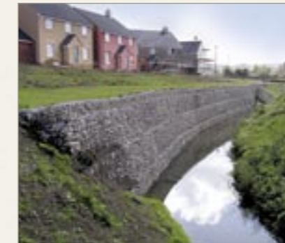
Grawitacyjna ściana oporowa z materacami zabezpieczającymi przed erozją, Bristol, Anglia – 2004 rok.
