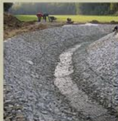
Wyłożenie przepustu, Autostrada A4, Krzywa, Polska - 2005 rok.
