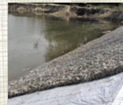
Zabezpieczenie brzegu jeziora materacami z kraty Weldmesh®, Czeszów, Polska - 2005 rok.
