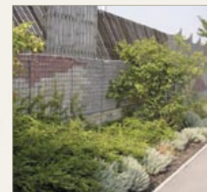
Ogrodzenie Centrum handlowego z wstawkami z kolorowego betonu. Anglia - 1998 rok.
