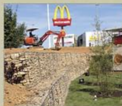
McDonalds, Chantier, Francja - 2004 rok.
